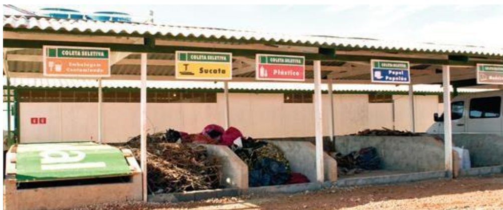
Figura 9- Ilustração de exemplo de baias de segregação e armazenamento temporário de resíduos
